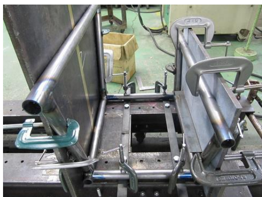
リアセクション最後部の製作
