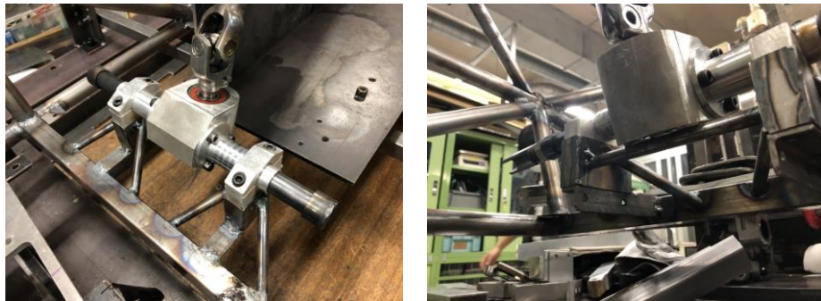
Fig. 7 ラックマウントステアの溶接
