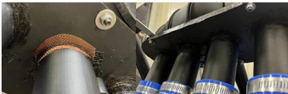
Fig1. 銅メッシュの埋め込みイメージ（左）、作業終了後外観（右）
