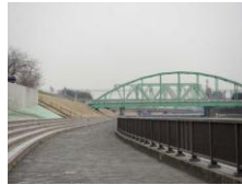
(D) 北赤羽 中の橋
