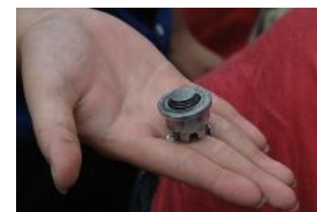
Fig.4 脱落したクラウンナット
