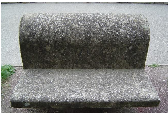
凍害（凍結融解作用）により表面がスケーリングしたコンクリートのベンチ（フィルミニの文化会館の敷地にあるベンチ）
