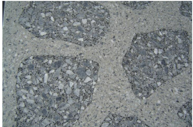
銅スラグ細骨材と石灰石を用いたテラゾのカーテンウォール
