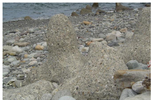
海岸に設置されたテトラポットの劣化（親不知の海岸）
