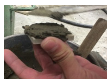
a) タイル裏モルタル
