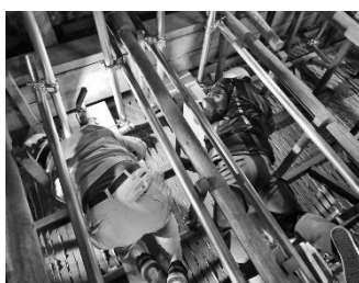
a) 伏せた体勢での施工
