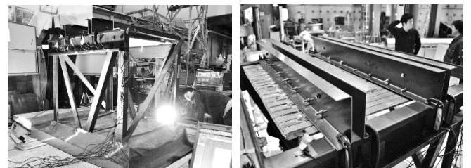
写真 1 加振フレーム 写真 2 実構造部材の取付け状況
