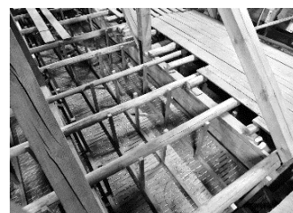
写真5 営業室天井の支持部材
