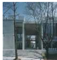
a) 工学院大学八王子校舎 15 号館
