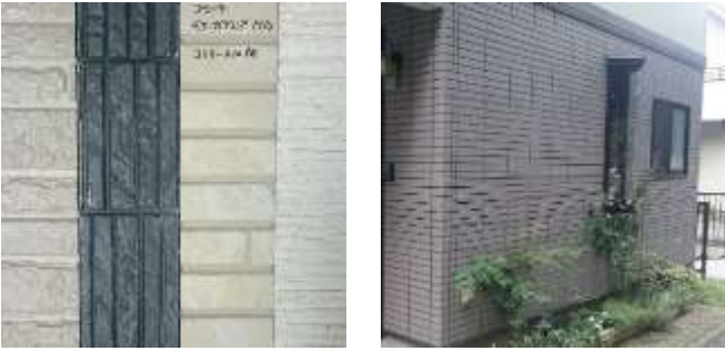
a) 製品サンプル b) 施工例 写真1 窯業系サイディングの施工状況
