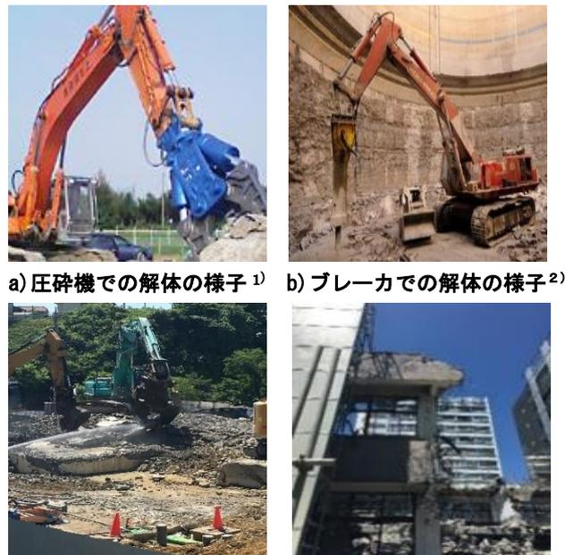
写真1 コンクリート解体時の様子
