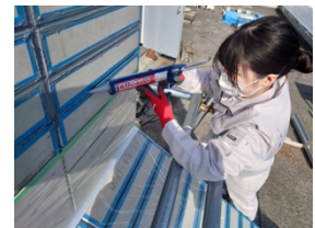
f) 1次シーリング施工
