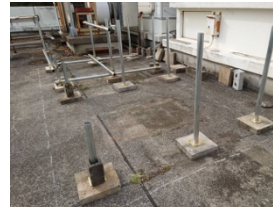
c) 単管パイプ組み立て
