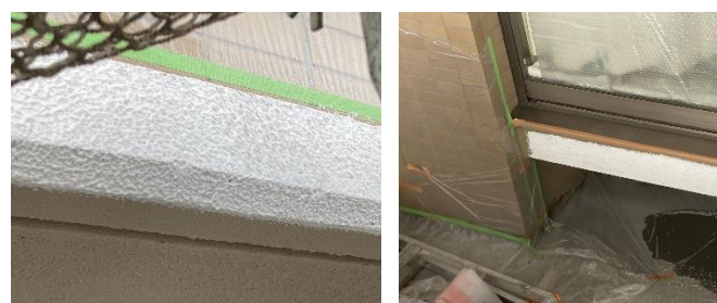
a)仕上塗材施工後の外壁
