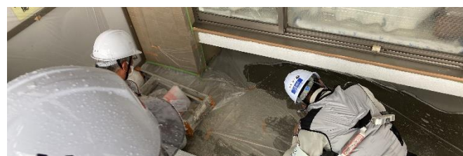
c)施工中の様子
