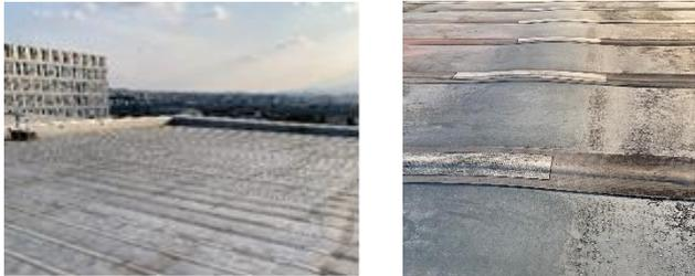
a) 冷間圧延屋根鋼板改修前 b) 経年変化によるたわみ
