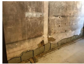
a) 1 階 北面東側の補修既存土壁
