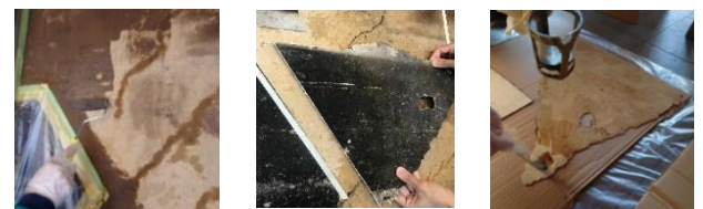
a) アクリル樹脂補修 b) 剥がれかけ漆喰面の切断 c) 樹脂プライマー補修
