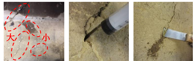
a) 補修前ひび割れの様子 b) 特殊アクリル樹脂注入 c) 目止め
