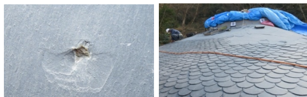
c) パイライトを含んだ試験体 d) 葺替え工事の様子 写真 1 天然スレート屋根用既存材の採取場所と採取した試験体 (研究 2)
