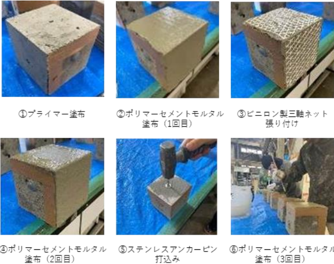
図4 外壁複合改修工法の施工手順
