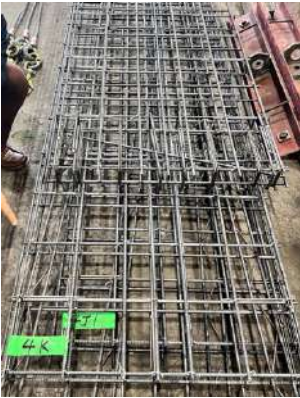
写真 1 PCa 実部材の鉄筋
