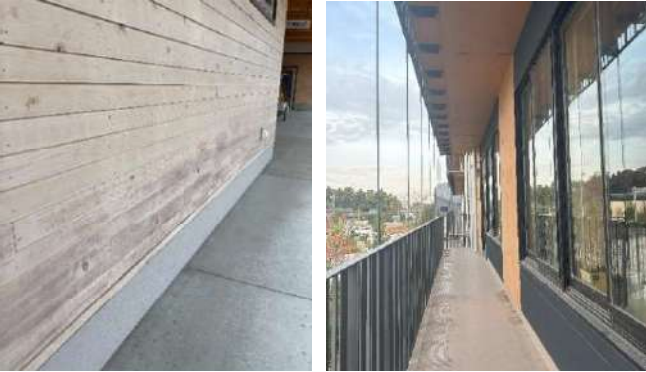
a) 木曽町役場の外壁 b) 雨掛かりに配慮した設計 写真4 屋外における木材の使用箇所(研究3)
