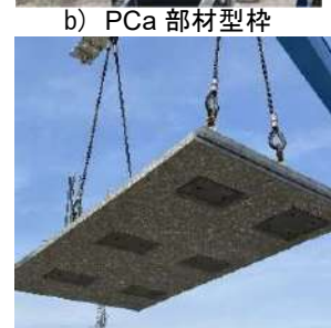
写真 1 現場施工 2 層打ち仕上げ PCa 部材パネル
