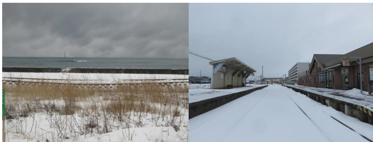
左：大きく曲がった線路
