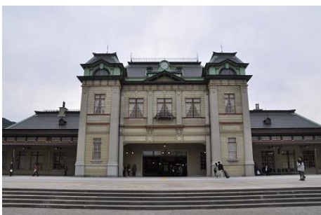
復元修理された門司港駅舎
