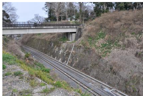
堀の中に敷設された水郡線の線路
