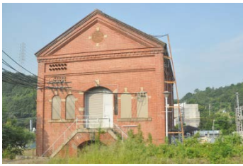
↑ 煉瓦造りの深日変電所
