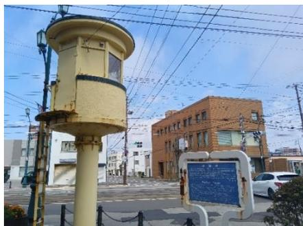
これは操車塔であり、かつてこの交差点の路面電信用信号とポイントの制御を人の手に行うために造られたものである。写真にある青い看板によると函館市内に 6 基あったようだが、現在では自動化によってすべて消滅している。おそらくその自動化された後は画像の看板の真上にある四角い箱で行っているのではないかと考えている。そしてこの十字街から先谷地頭まで乗車するのは右にある名探偵コナンのラッピング
