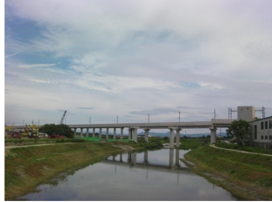
回送線と北海道新幹線の建設現場
