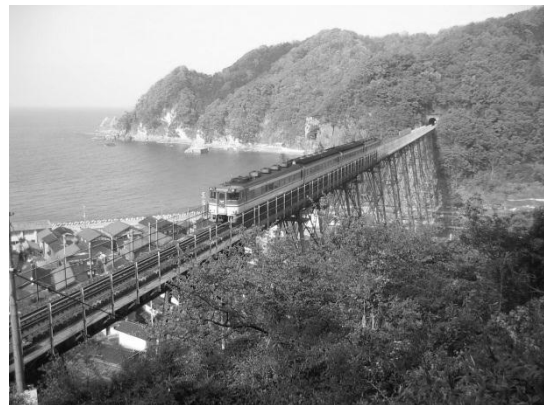
解体前の余部鉄橋
