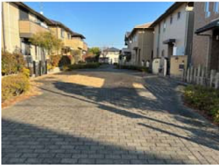
コモンスペースと住宅地 (いかるがの里服部：奈良県)
