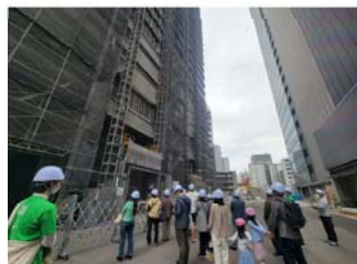
工事現場見学会
