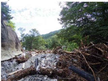
図5:道路がはがされ岩盤が露出した様
