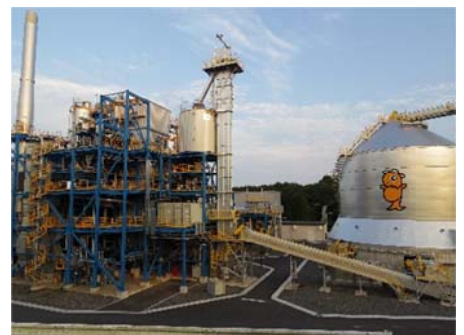
図7:バイオマス発電所
