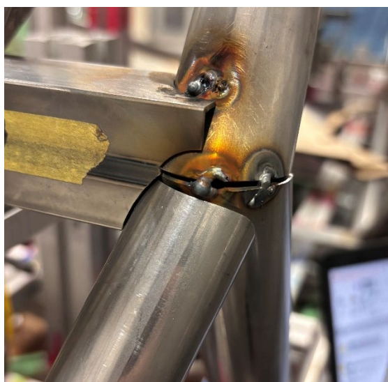
Fig.7 リアセクションの製作
